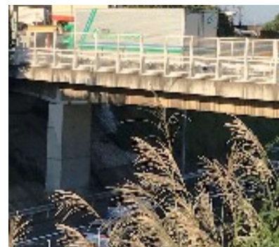
▲中央高速道路にかかる緑橋
