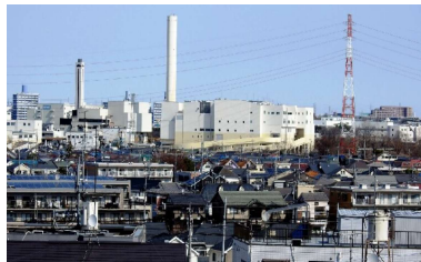
▲中央煙突の建物が新焼却施設
