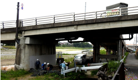
▲土のう工事の滝合橋付近(5月28日撮影)
