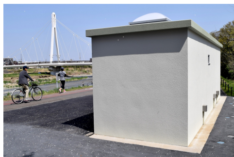
浅川右岸遊歩道に トイレ新設
