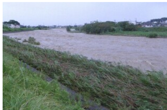
増水した浅川・一番橋下流
