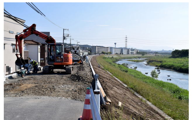
南平から平山橋方面を見た堤防道路工事風景
