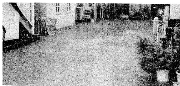
昨年9月12日、大雨で床下浸水の被害を受けた南平7丁目地域(写真 中野)
